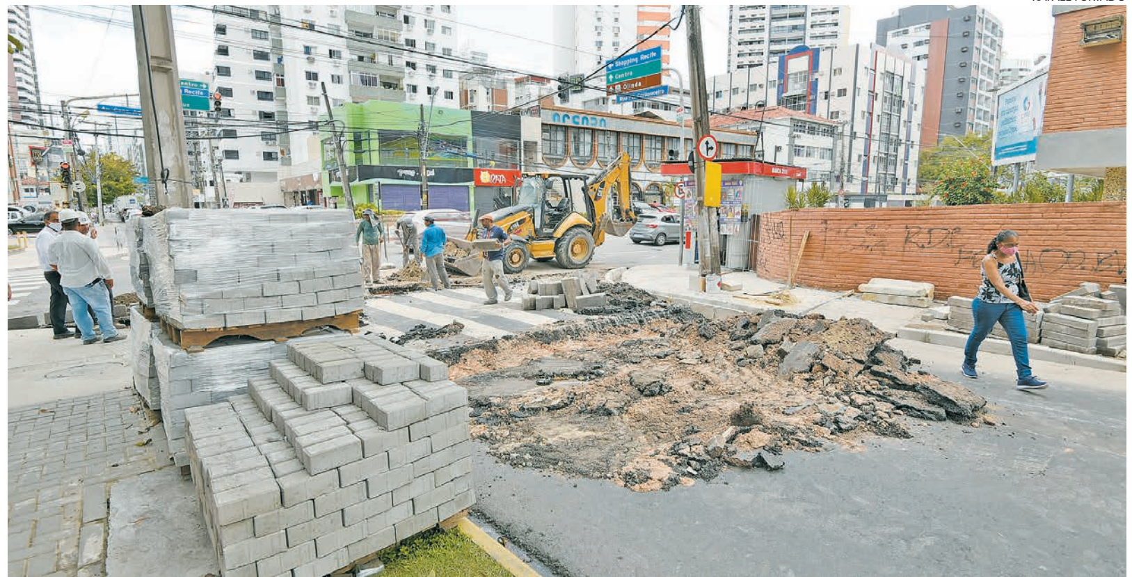
CTTU montou esquema especial de trânsito por causa do serviço, que faz parte do projeto Calçada Legal, da Prefeitura do Recife
