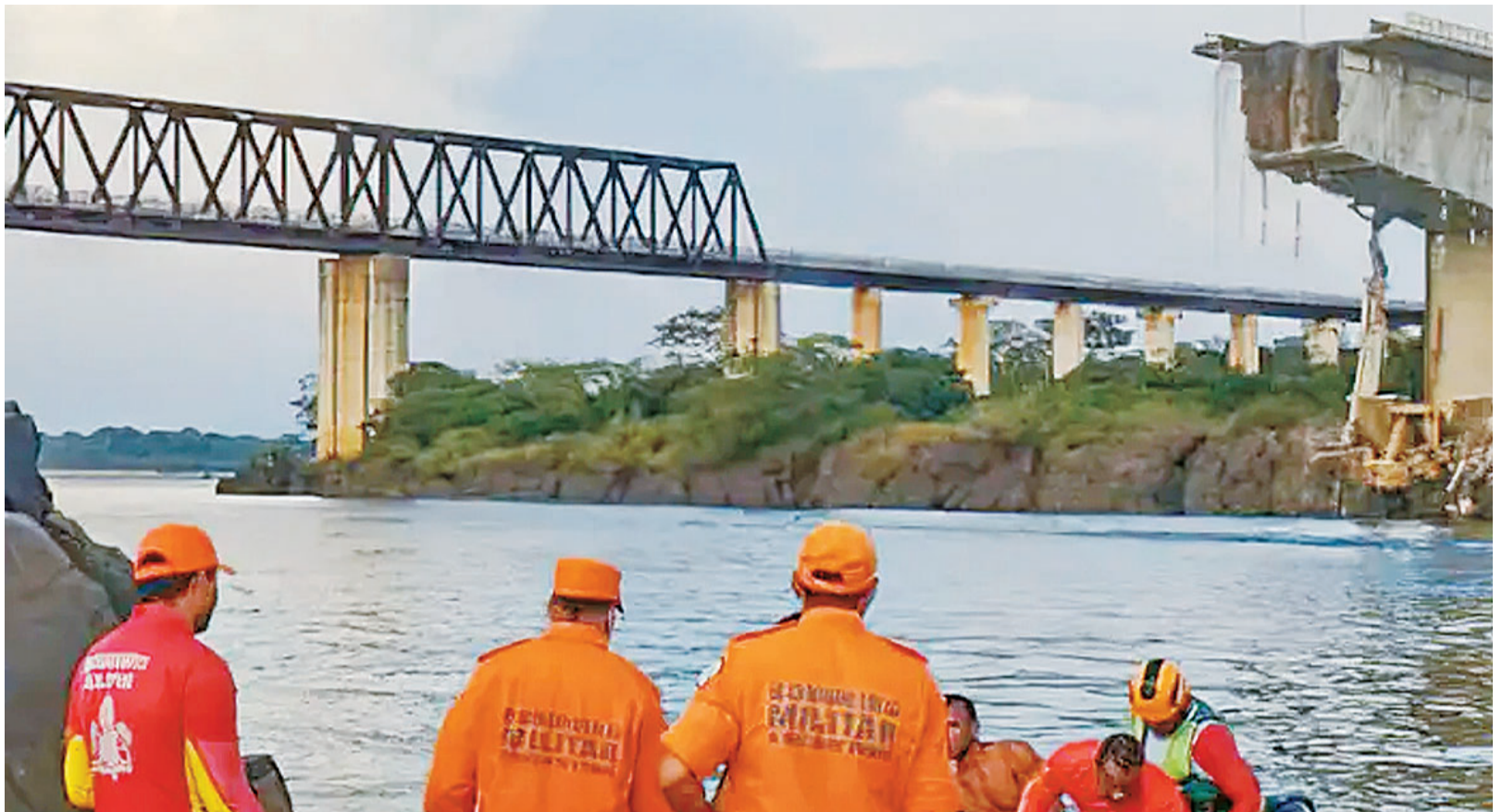
Quatro mortes foram confirmadas pela PM e Corpo de Bombeiros. Pelo menos 8 veículos passavam pela ponte na hora do desastre
